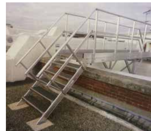
Passerelle de circulation
