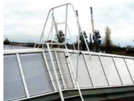
Saut de loup et chemin en toiture
